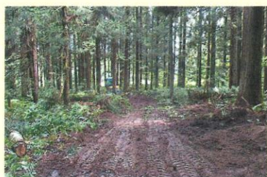
搬出に欠かせない作業道の整備
