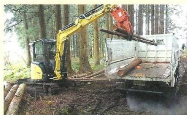
導入したBHでの間伐材の集材
