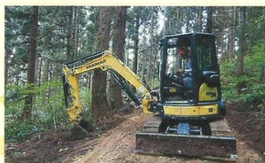
導入したBHでの路網整備
