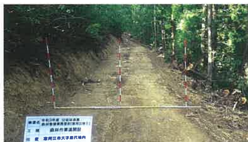
森林作業道：簡易な構造で木材搬出に使用
