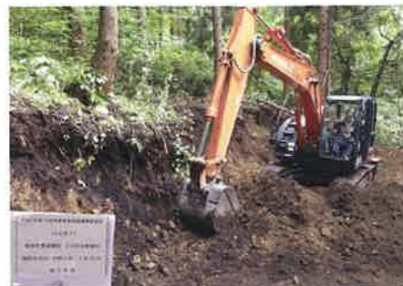
森林作業道の開設
